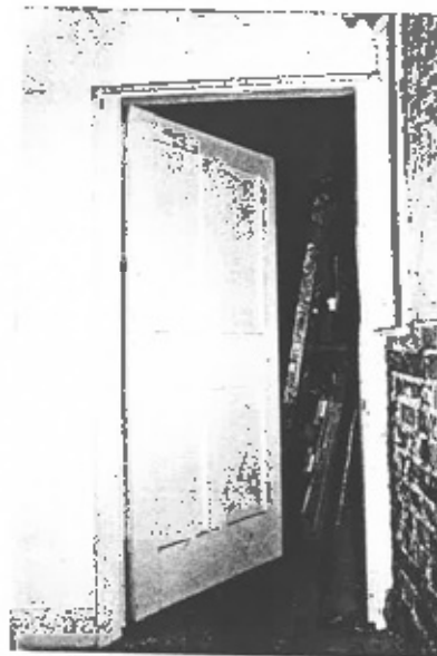
Door of Room E1
